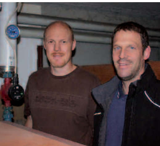
Werner Burtscher und Monteur Werner Rumpold vor der neu installierten energiesparenden Heizungs-umwälzpumpe.
