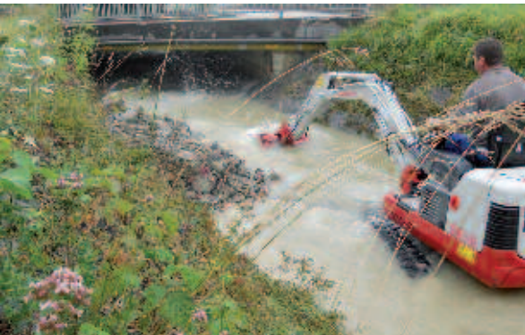
Ausbaggern der Anlandungen, Rickenbach
