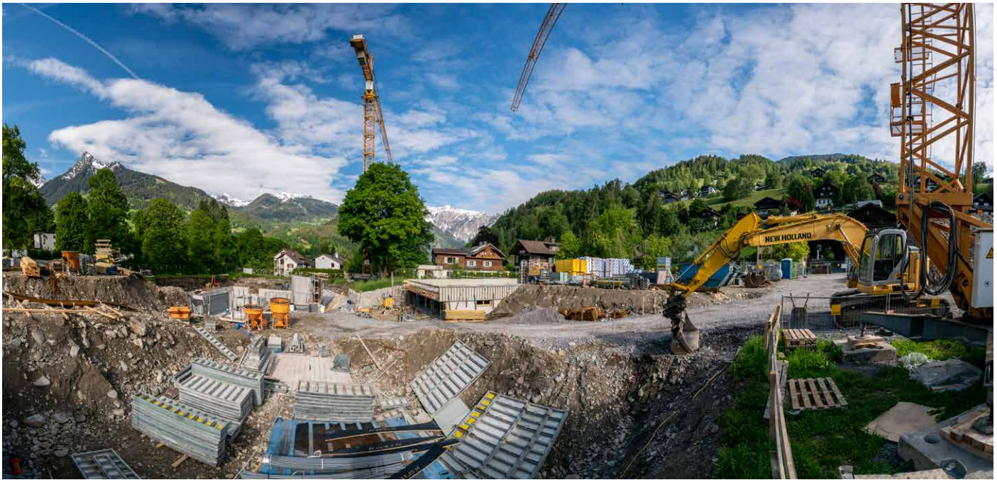
Baustelle Alpstein – Foto: Johannes Netzer
