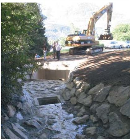
eine Abflussdrosselung eingebaut worden. Dadurch können im alten Wasserlauf maximal nur noch rund 25 l/s abfließen. Die darüber hinausgehenden Wassermengen werden über die neue Ableitungsverrohrung zum Vermülsbach geführt.
