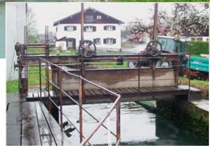
Giessenbaches eine automatische Rechenreinigungsanlage wird installiert, die Anlage wird auf den letzten Stand im Bezug auf Steuerungstechnik, autom. Störungsmeldung via SMS und Stromverteilung gebracht
