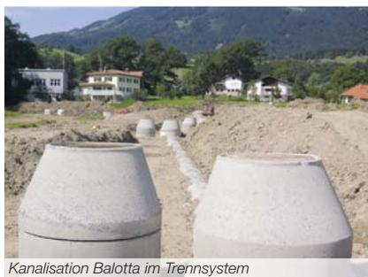
Kanalisation Balotta im Trennsystem
