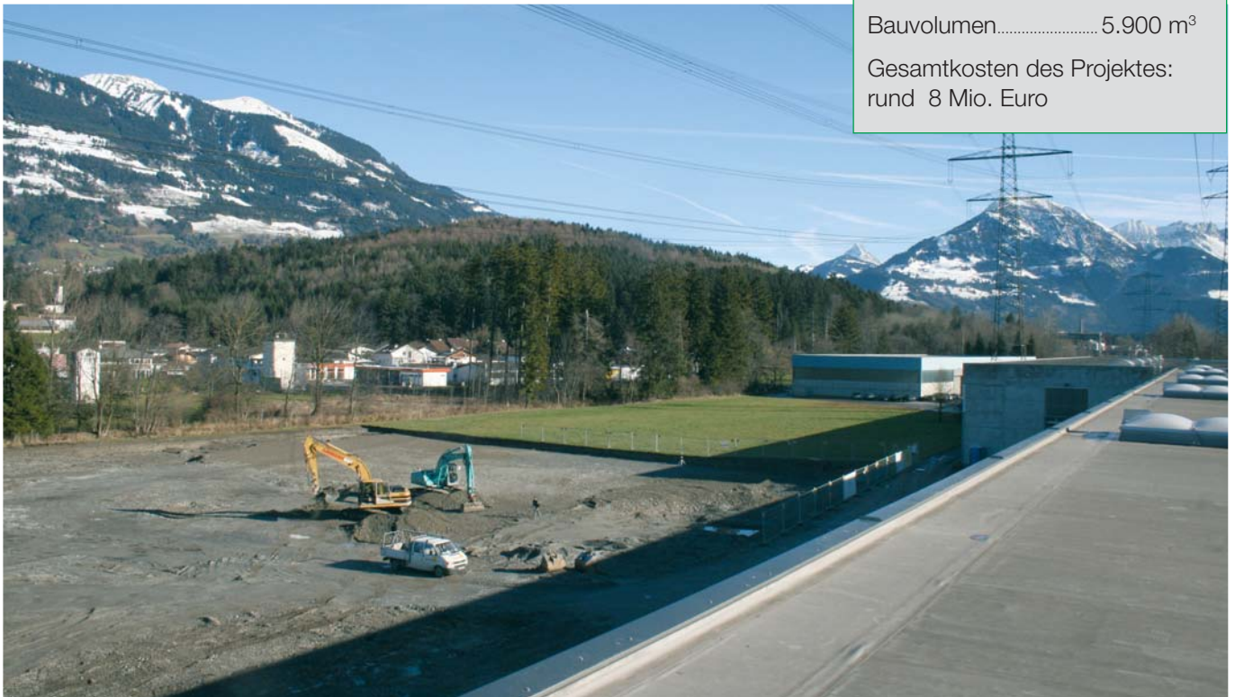
Ansicht vom Dach des Hochregallagers: Bagger arbeiten auf dem zu bebauenden Grundstück, im Hintergrund: Rohrlagerhalle
