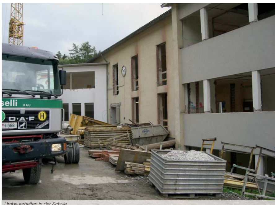
Umbauarbeiten in der Schule
