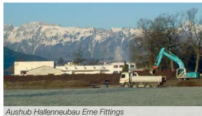
Aushub Hallenneubau Erne Fittings
