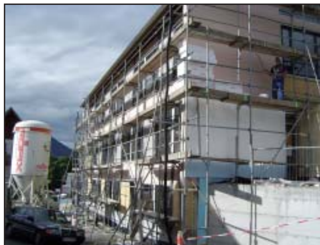
Die Isolierung wird angebracht
