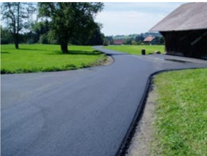
Neue Asphaltdecke - Güterweg Ried
