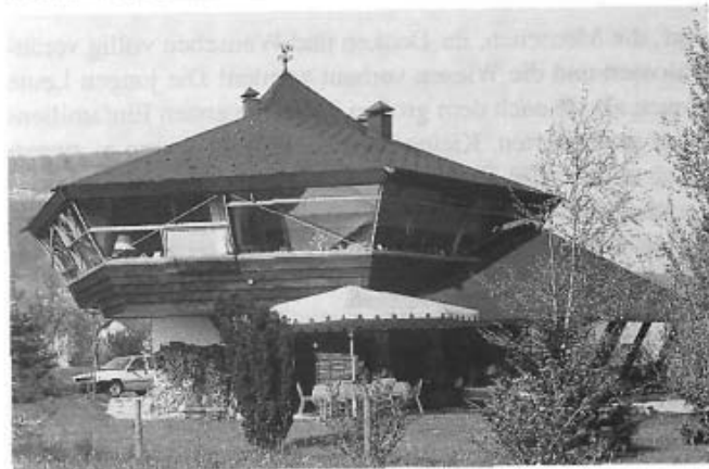
Bild 12: Außergewöhnliche Architektur: Fattstraße 37.
