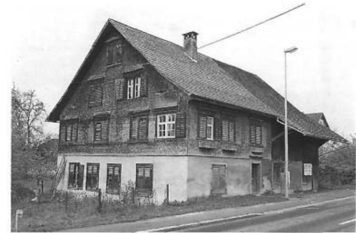
Bild 5: Kleines Rheintalhaus. Schulstraße 4, Knores. Erbaut 1873, abge- brochen 1984.
