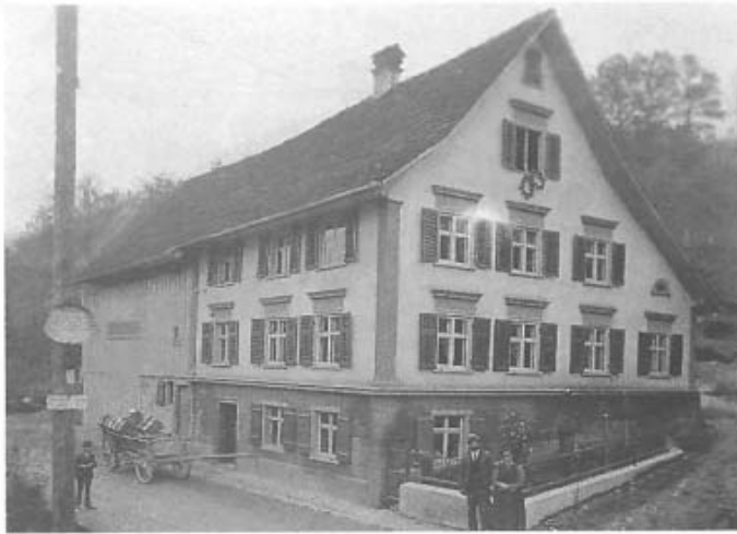
Bild 6: Großes Rheintalhaus. Kirchstraße 2, Rich- Höfles . Erbaut vor 1760, abgebrochen 1973.
