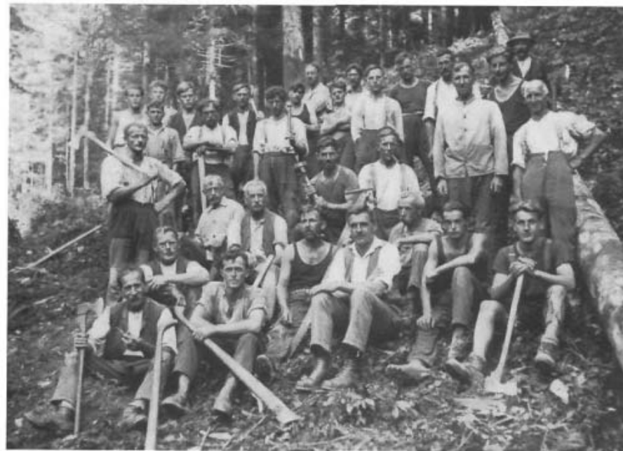
Bild 3: Arbeiter an der Neuen Bucherstraße 1933
