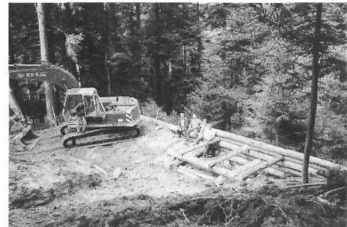
Bild 11: Krainerwände ermöglichen den Bau von Serpentinien am steilsten Hang.
