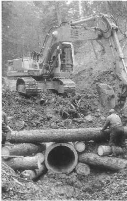
Bild 12: Ein Damm über den Gitznergraben wird aufgeschüttet.
