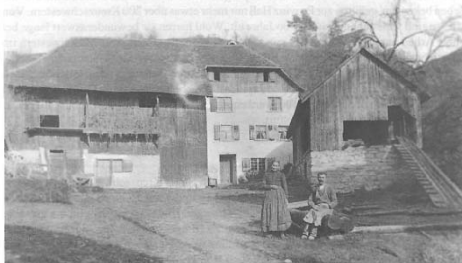
Draiers Seego am Holzerbach im Unterlinden. Hier wohnte bis 1924 Agatha Böhler, die mit ihrem Besitz den Grundstein für den Krankenpflegeverein legte.
