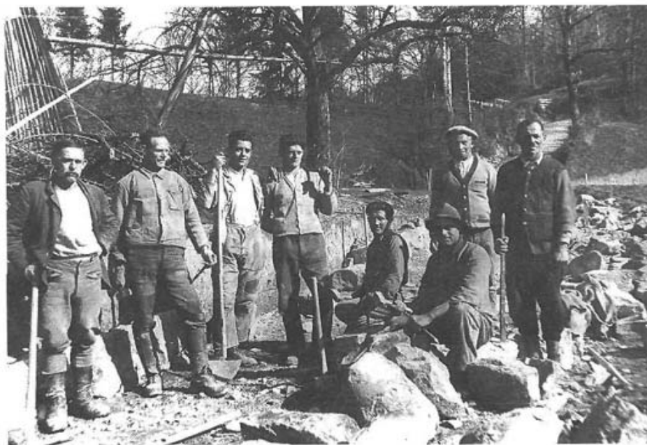
Neubau der Bildsteinerstraße 1933. Ohne Maschinen schafften es Bildsteiner und Wolfurter Männer (u. a. Gasser Gebhard, Lenz Josef, Fischer Eugen), die steile Straße nach Ankenreute für die Autos umzubauen. Die erste Fahrstraße war schon 1792 durch die Platte gesprengt worden.
