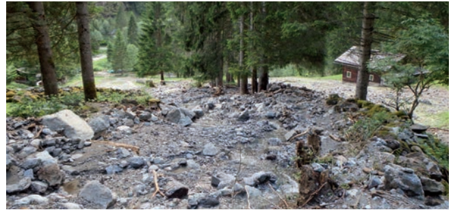
Auch im Bereich des Gasthaus Fellimännli richteten Muren erhebliche Schäden an
