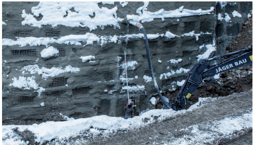
Die Arbeiten im Bereich der Höllbrücke sind auch während den Wintermonaten voll im Gange
