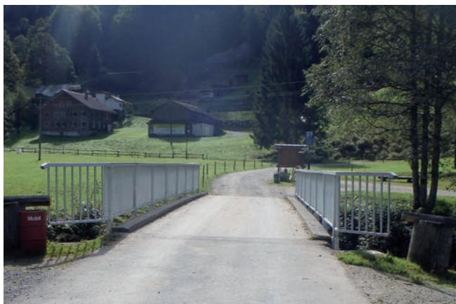
Die Wührebrücke erstrahlt nach der Sanierung wieder in neuem Glanz
