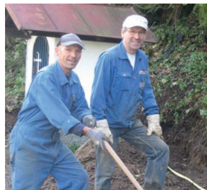
Kessler Hannes (li.) und Walter Bargehr bei Grabungsarbeiten zur Errichtung der Straßenlaternen
