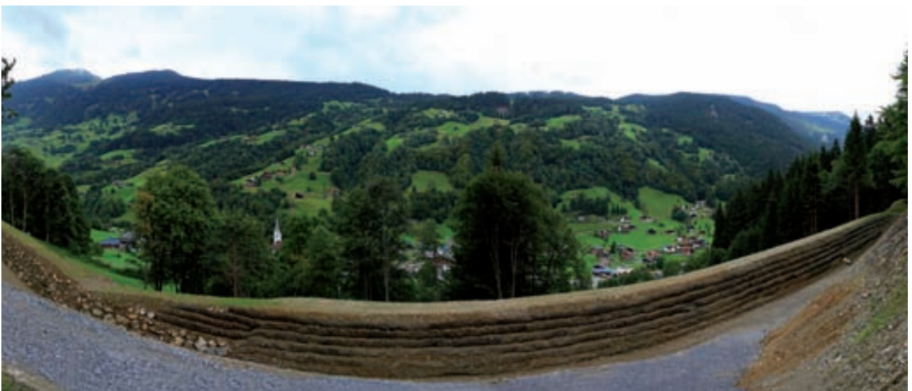
Das Projekt Steinschlag „Schattwald“ wurde dieses Jahr abgeschlossen
