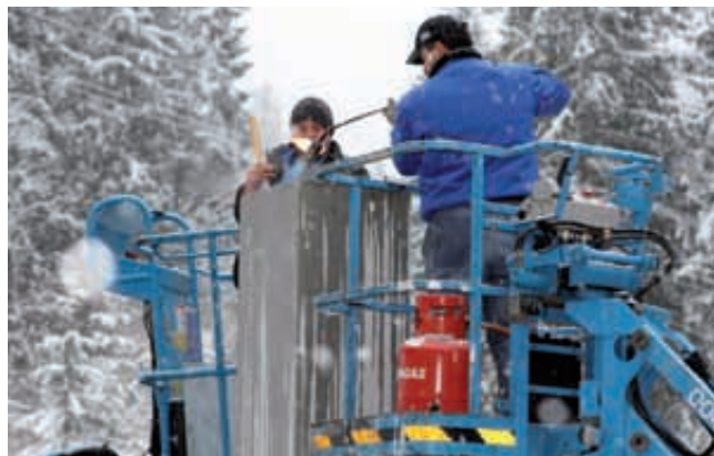
Die Vorarbeiten für den Dachstuhl gingen trotz Schneefall voran
