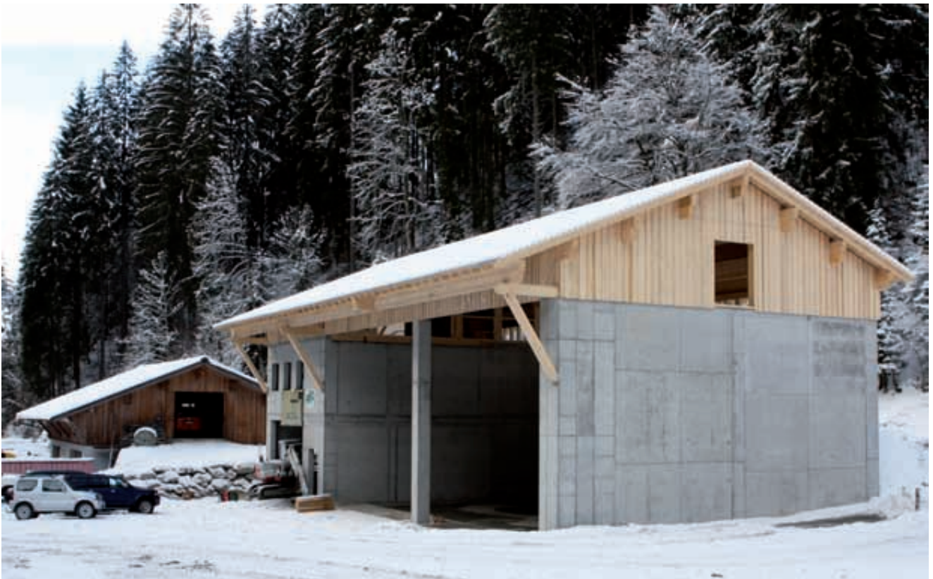
Trinkwasserkleinkraftwerk „Buchen“ mit Hackgutlagerhalle (Platz für ca. 1.800 Schüttraummeter Hackgut), beim Schmelzhof
