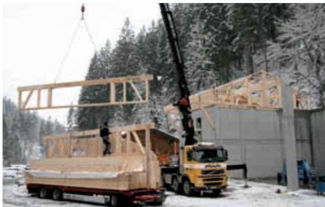
Mittels Kran wurden die fertigen Holzelemente aufgerichtet
