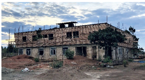
Seminarhaus in Mafinga im Bau
