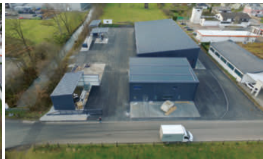
November 2017, die Gebäude sind fertig und asphaltiert, Innenausbau kann beginnen
