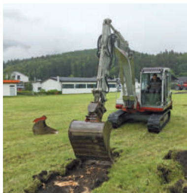
Sondierung Baugrund
