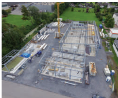
Ab Juni werden die Gebäude errichtet
