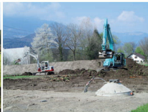
Im April 2017 starten die Erdarbeiten
