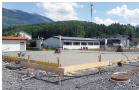
Der erste Betonabschnitt im Mai
