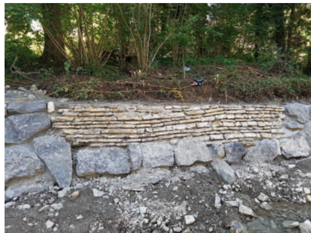
Zerfallene Uferverbauung durch „Grobsteinschichtung in Beton verlegt“ ersetzt, gut erhaltene Abschnitte der Uferverbauung werden neu verfügt
