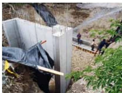
Arbeiten an der Brücke - Sägegasse
