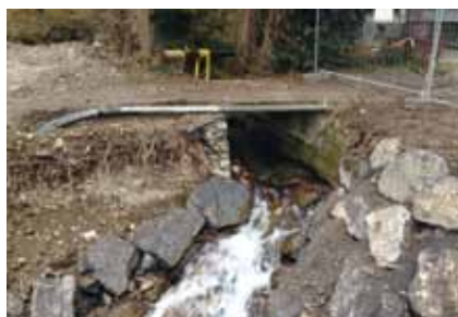
Brücke Sägegasse alt
