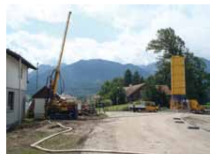
Düsenstrahlarbeiten an der Brücke - Kreuzstraße
