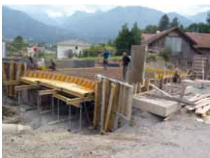
Bewehrungsarbeiten Tragwerk - Brücke Kreuzstraße
