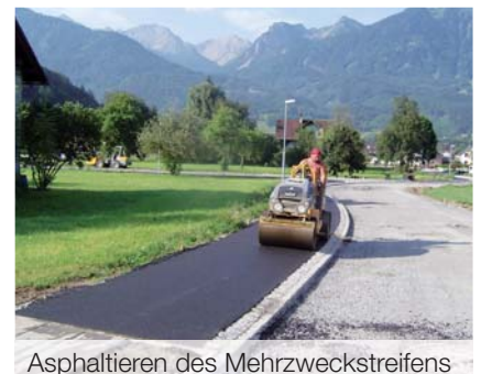
Asphaltieren des Mehrzweckstreifens
