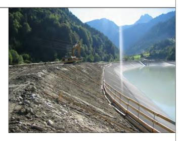
Die eigentlich für die zweite Bauphase 2004 geplanten Schüttungen über die alte bestehende Kronenhöhe hinaus werden bei den Umschließungsdämmen (West, Nord- und Ostdamm) bereits bis spätestens Ende Oktober 2003 fertig gestellt sein. In diese Bauphase fallen 2004 in weiterer Folge die Schüttung der Südböschung (bergseitig), die Asphaltbetondichtung sowie Rekultivierungsarbeiten. Den Abschluss bilden die Inbetriebnahmeversuche (Probestau).
