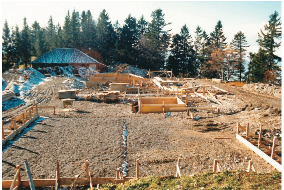
Im Jänner 1988 wurde bereits die Bodenplatte betoniert.
