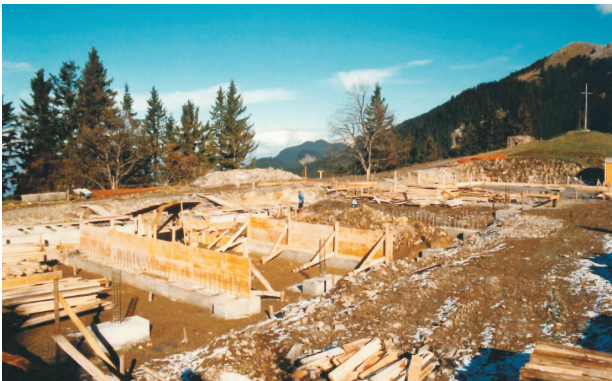
Monatelang wurde bis tief in die Nacht auf der Baustelle gearbeitet.
