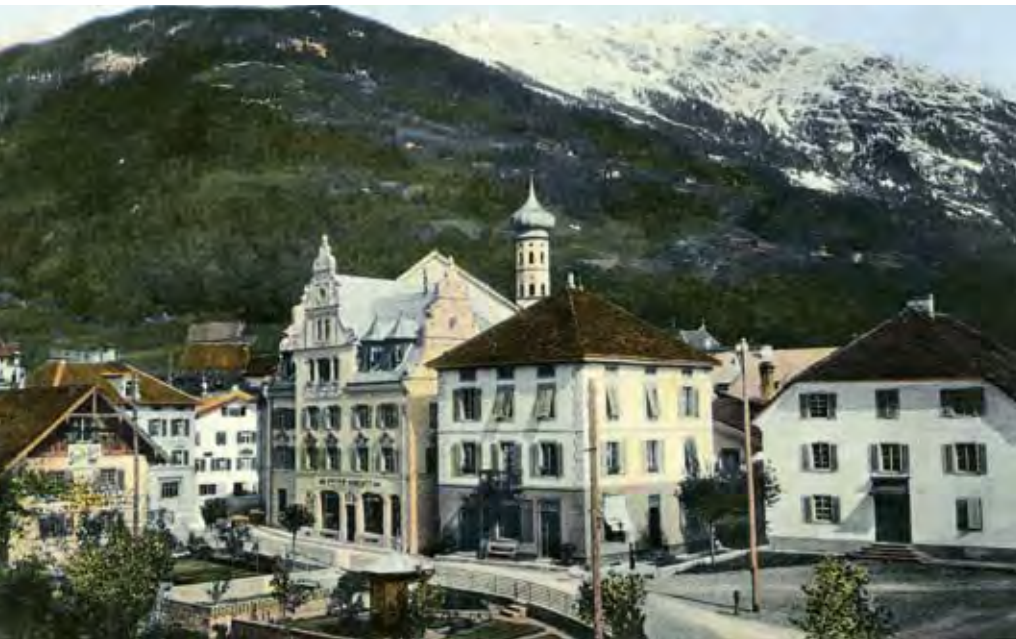
Blick von der Litzbrücke (Außerlitzstraße) anno 1911
