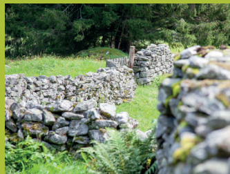
Trockensteinmauern Maisäß Rütli (2019) Gargellen
