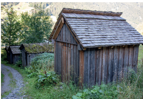
Gais Schärm Richtung Alpe Valschaviel, bei der Bachfassung
