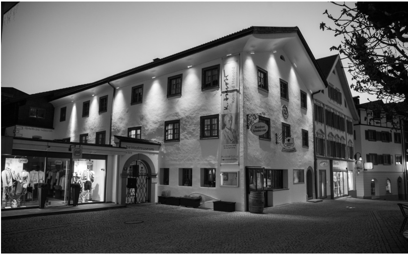
Passend zur sanften Sanierung zum 40. Geburtstag wurde das Montafoner Heimatmuseum in Schruns auch mit einer neuen Außenbeleuchtung richtig in Szene gesetzt.
