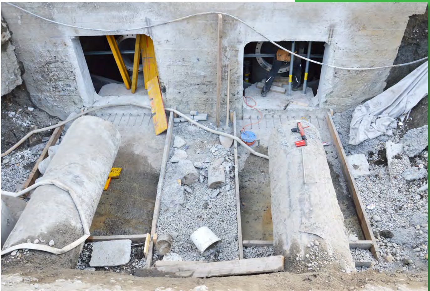
Ausbau der schadhaften Rohre und Erstellen der Öffnungen zum Einbau der neuen Druckrohre
