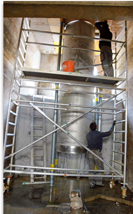
Der Stahlrohrschaft ragt aus der trockengelegten Pumpkammer in die Höhe, hinter dem Gerüst die Strömungswände.
