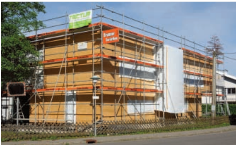
Die Arbeiten am neuen Kinderhaus Pertinsel liegen exakt im Plan.
