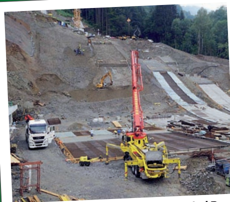
Die Montafoner Schanzen können bei Baustellenbesichtigungen live erlebt werden.
