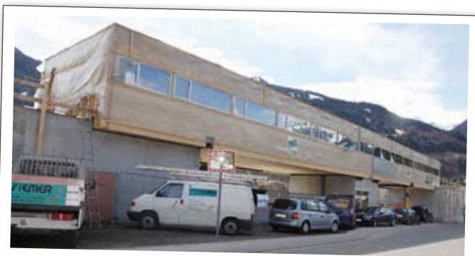
Der Neubau der mbsBus-Zentrale in der Schrunser Batloggstraße hat sich bereits mehr als bewährt.
