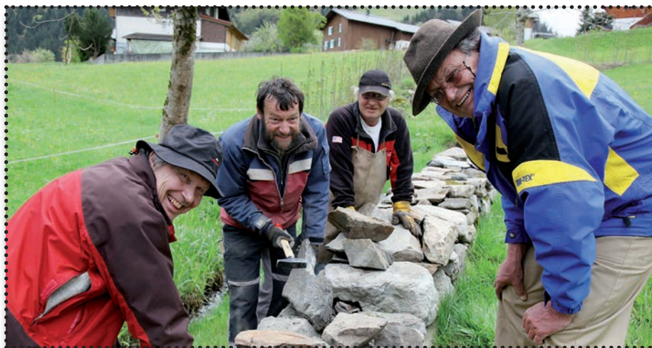
Der Schweizer Steinmauer-Profi Martin Lutz (mitte) zeigt den Teilnehmern ein längst vergessenes Handwerk beim Wiederaufbau der Via Valtellina.
