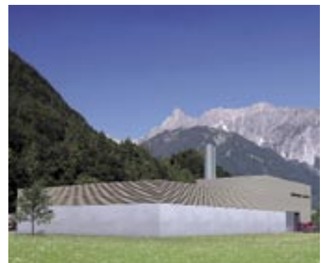
So wird das Heizkraftwerk einmal aussehen.
