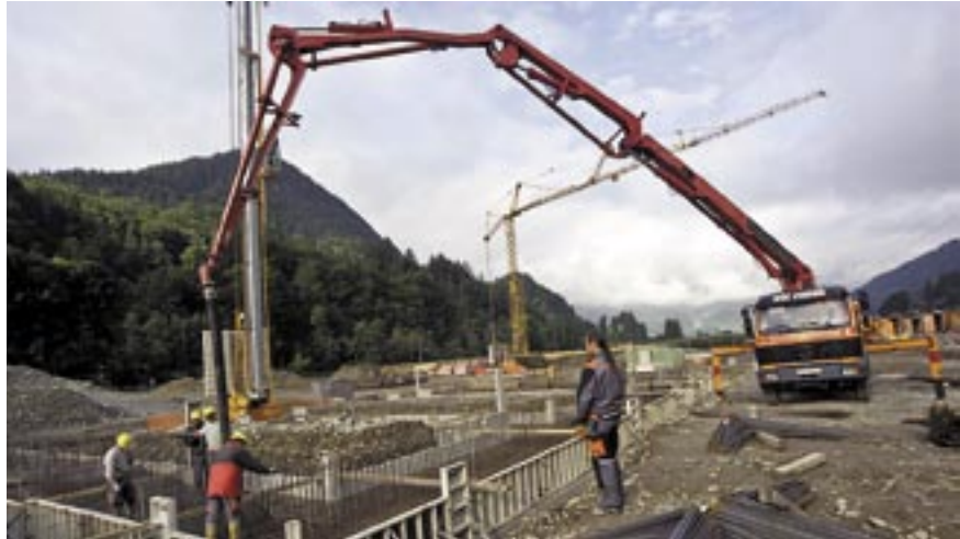
Die Bauarbeiten für das Biomasse-Heizwerk laufen auf Hochtouren.
