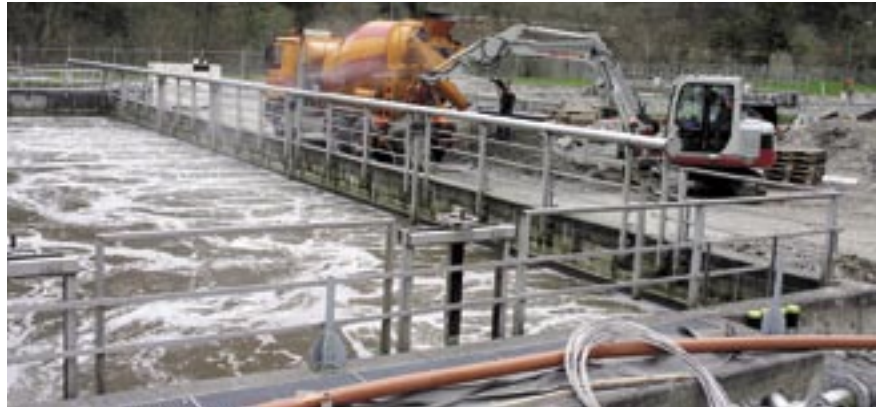
Die Sanierungsarbeiten bei der ARA Montafon liegen voll im Plan
