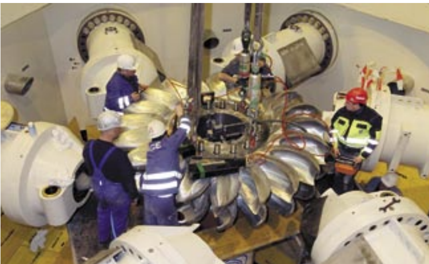
Bis Kops II endgültig in Betrieb gehen kann, ist noch viel Arbeit notwendig.
