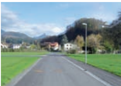
Wasser- und Kanalausbau
