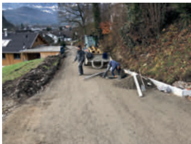
Gurtgasse - Einbautenangleichung vor Asphaltierung
