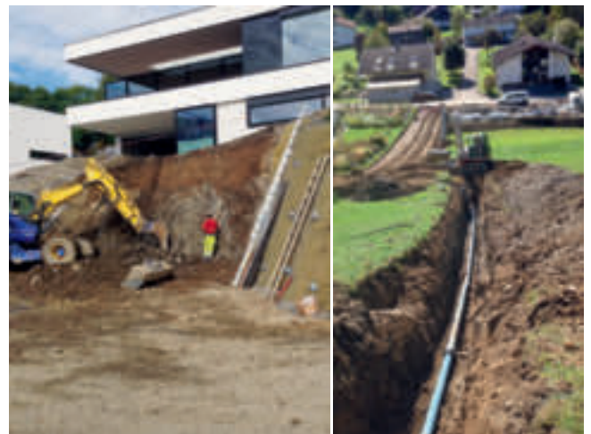
Felsvernetzung - Einfahrt Gartis Wasserleitungsbau Gartis
