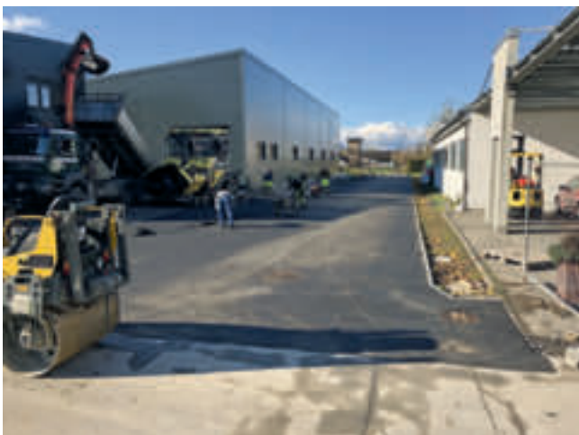
Asphaltierung Erschließung Säggacker
