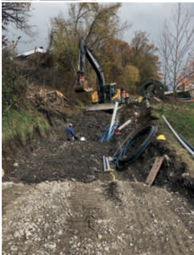
Straßenausbau Gurtgasse mit Leitungslegungen
