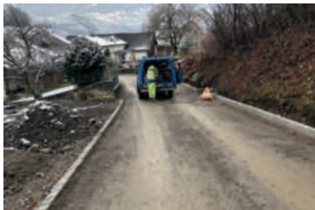
Gurtgasse - Prüfmaßnahmen vor der Asphaltierung
