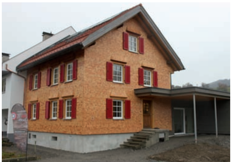
Generalsanierung Wohnhaus Gaßner in Schllins
