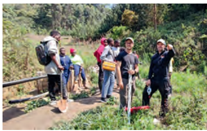
Planung neuer Wasserleitungen
