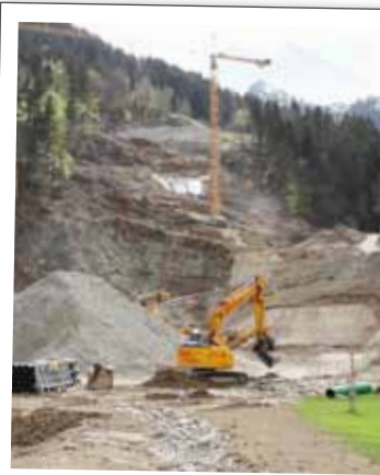
Derzeit sind in der Zelfe große Maschinen im Einsatz.
