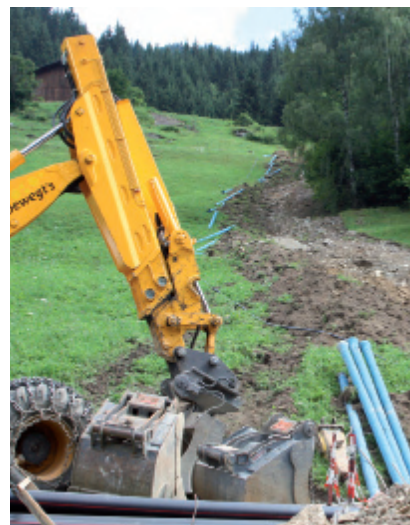
Die Grabungsarbeiten , wie hier in der Parzelle „Buchen“, sind voll im Gange
