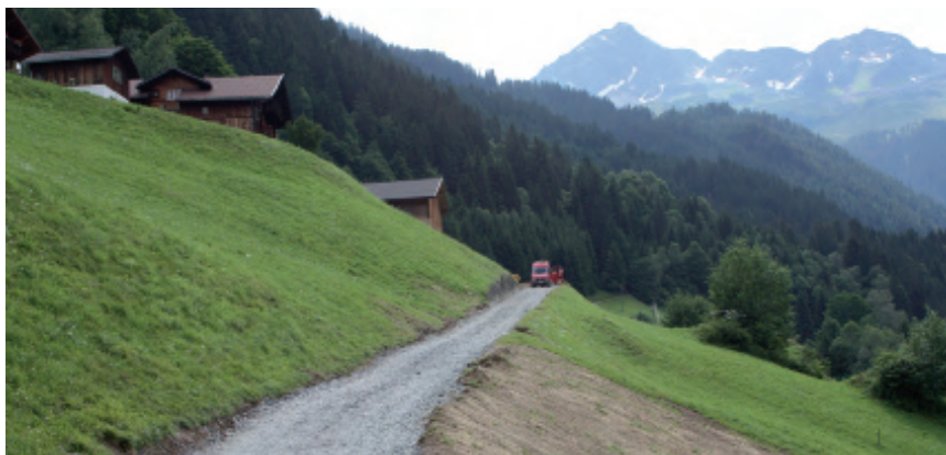
Die Sanierung des Güterweges „Buchen“
